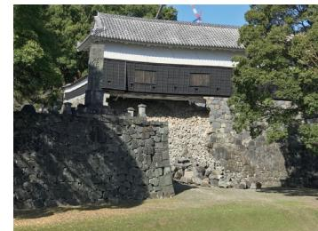
馬具櫓は、熊本城の南口を守る1階建ての櫓。馬具を納めていたと伝えられている櫓で、本震によって石垣に膨らみが生じ、度重なる余震の影響により5月10日に崩壊。現在も未だ修復が完了しておらず、震災の凄さを目の当たりにすることができる。
